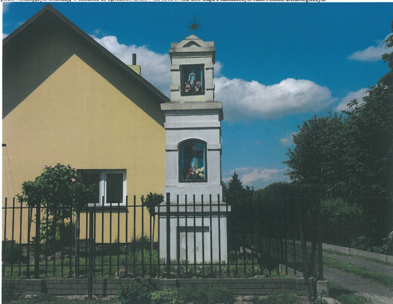
Widok na południowo-zachodnią elewację kapliczki
